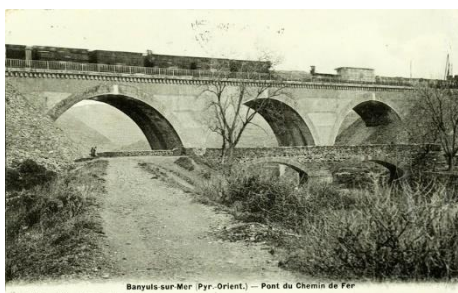
Le pont ferroviaire sur la Baillaurie. Carte postale, ers 1900. Vue de la face ouest. Un pont de pierre assure alors le passage piéton et automobile.
