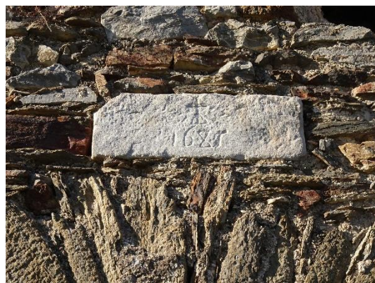
Mur sud d'une extension bâtie en 1685 contre le flanc de l'église.
